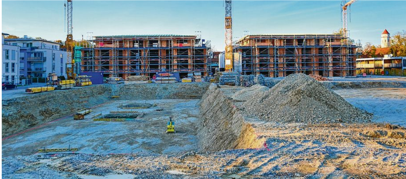
Die Bauarbeiten im Wohnpark Heilig-Kreuz-Straße in Kaufbeuren gehen voran. Jetzt begann der Bau weiterer Gebäude mit Mietwohnungen, für die bereits die Baugruben (Vordergrund) ausgehoben sind. Zudem feierten Handwerker, Bauherr, Planer und städtische Vertreter Richtfest an die Rohbauten (Hintergrund).
